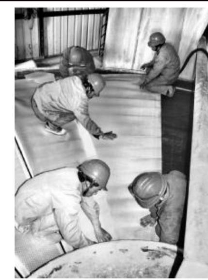
为提高氧化铝产品质量,为焙烧炉输送合格的氧化铝物料,近日,2万吨氧化铝厂六车间对焙烧工段平盘系统的滤布进行检查换布,并进行检修消缺。经过两个小时连续作战,提前完成了检修任务,为全年生产任务的顺利完成赢得了宝贵的时间。图为检修员工正在更换滤布。
