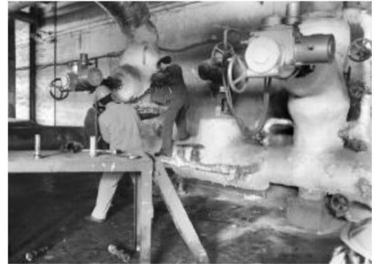
11月21日,分厂组织人员对2号汽轮发电机组进行计划性消缺,工期60小时。主要包括凝汽器高压水清洗、空冷检查等14个检修项目。参战人员克服立体交叉作业、空间狭小等不利因素,加班加点,确保了设备按计划试车。图为检修人员正在拆卸主蒸汽母管法兰螺丝。摄影报道 陈文郁 柴美霞
