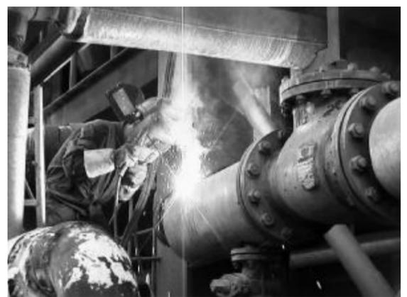
由于受高温、高压、高碱等生产条件的影响,管道泄露点多一直是困扰80万吨蒸发系统正常运行的主要因素,近日,80万吨四车间对蒸发系统所有管道弯头进行了包焊技术处理,可使弯头使用期限延长三到四倍。图为焊工正在对蒸发系统管道弯头进行包焊技术处理。
