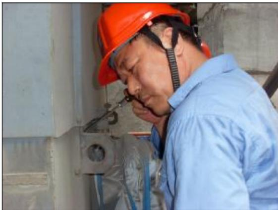
近日,随着气温不断升高,热电厂锅炉车间增加班组点巡检次数,对引、送、排、磨等转动设备的温度、振动等逐个部位仔细测量,调整转动设备的冷却水量,使每台炉保持在25吨每小时左右,保证冷却效果。车间还加大转动设备的润滑油检查力度,发现变质或轴承带油不良的及时更换、补充,并做好台账记录,保证设备在夏季高温时运转正常。图为车间员工通过设备运转声音判断故障。
