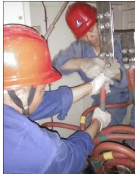
近日,水电分厂综合检修车间电气队,按照装备能源部科学合理调整种分变负荷的工作要求,组织精兵强将连续调整了三个家属区生活用电的主配电负荷,确保平稳度过夏季高峰用电期。图为工作人员在狭窄的开关柜内安装电接头。
