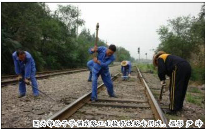
图为郭徐子带领线路工们检修铁路专用线。摄影 尹峰
