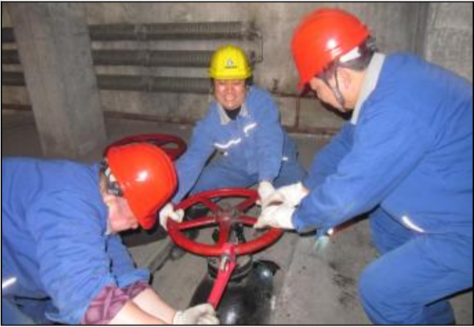
3 月 16 日，第一氧化铝厂空压站车间在巡检中发现 3 号低压机中冷进水阀、电机冷进水阀泄漏严重，为了确保设备正常运转，不影响生产，车间决定立即带压更换阀门。车间主任、书记带队组成 16 人的突击队，合理安排更换阀门流程，全力确保施工安全。经过 2 个小时的奋战，共切换阀门 8 个，提前 1 个小时顺利完成任务。图为员工在带压更换阀门。摄影报道 张利 张暖霞
